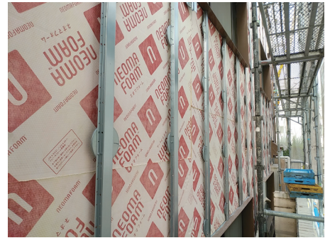
断熱材の施工後、不陸調整用のベースディスクが取り付けられ、その上に金属胴縁を施工。
