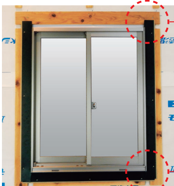
鋼板止水部材の上側T字部をサッシの上面に合わせる
