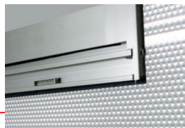
サイディングとサッシの隙間が小さくなるように施工
