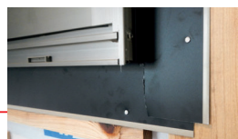
サッシ下に取り付けた部材T字部に被るように留め付けます
