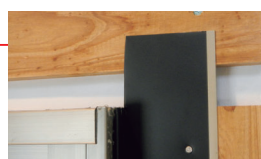
鋼板止水部材の上側T字部をサッシの上面に合わせる
