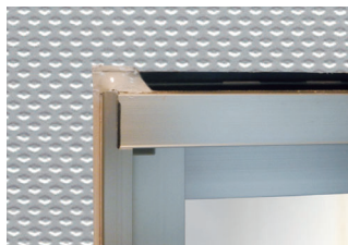
サイディングとサッシの隙間が小さくなるように施工
