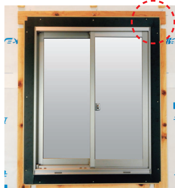
鋼板止水部材の上側T字部をサッシの上面に合わせる
