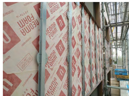
断熱材の施工後、不陸調整用のベースディスクが取り付けられ、その上に金属胴縁を施工。
