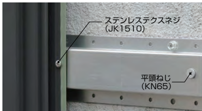
ステンレススクリュー(JK1510)を使用し、センターサイディングを留め付けてください。
