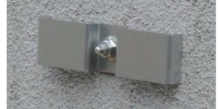
RC用アンカーを使用し、金属胴縁15アタッチメント(KN70)を固定してください。
