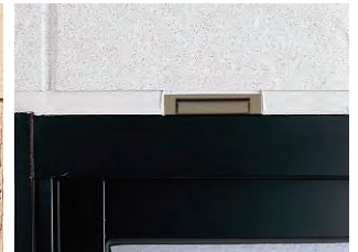
②シーリング施工後、モエン開口水抜き部材の養生テープをはがす。
