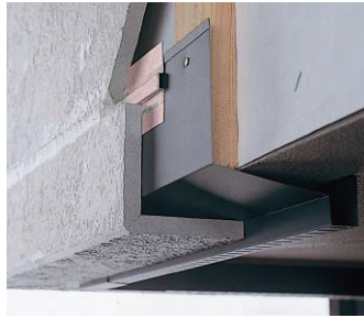
釘打施工時のオーバーハング部 (JOH8088)
