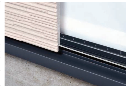
横張り通気金具工法の土台部 (FA850A)
