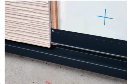
横張り金具工法の土台部 (FA150A)
