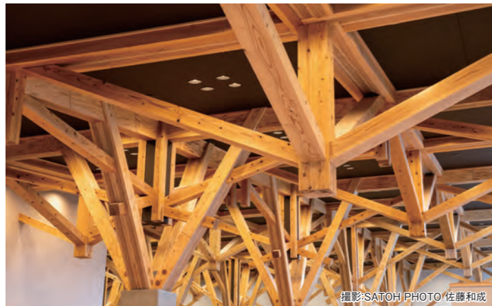
樹状V柱立体トラス部分とレシプロカル構造と張弦梁の部分により構成されている架構。メインとなるV柱や大梁でLVLを使用。単板積層材ならではの異なる木質の重なりが、ミルフィーユ状になりデザインの一部として機能しています。
