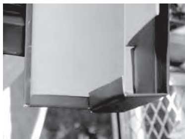
けらば水切110(85)軒先端部の加工例
