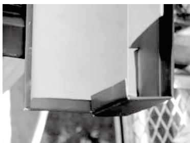
けらば水切110(85)軒先部の加工例
