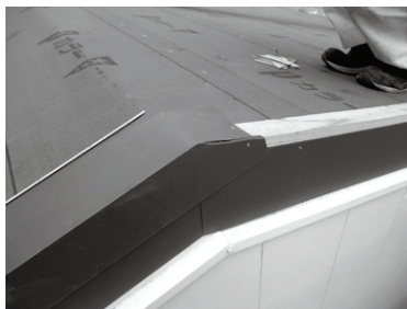
① 大棟部のけらば水切110(85)は、図のように切断加工します。
