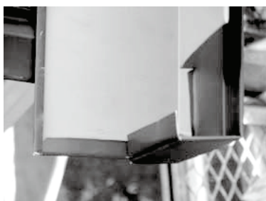
けらば水切110(85)軒先部の加工例
