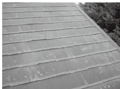
【屋根葺材の凍害】
