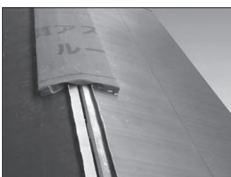
下葺材の施工
