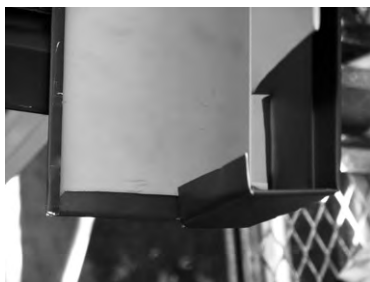
けらば水切85軒先部の加工例
