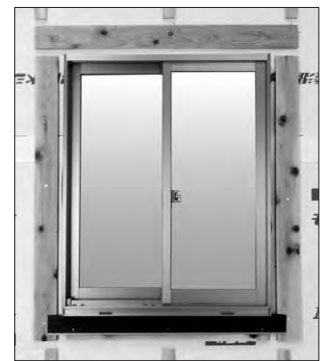
開口下に鋼板下地部材の取り付け
