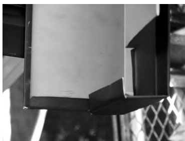
けらば水切85軒先端部の加工例
