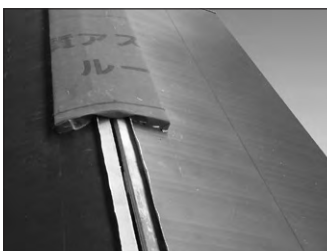
下葺材の施工
