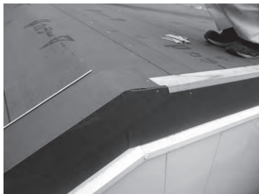
① 大棟部のけらば水切85(110)は図のように切断加工します。
