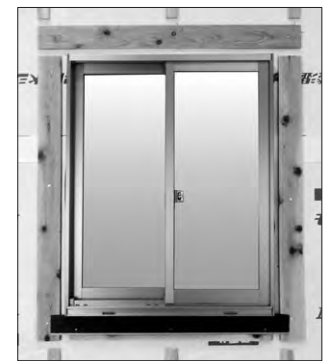
開口下に鋼板下地部材の取り付け
