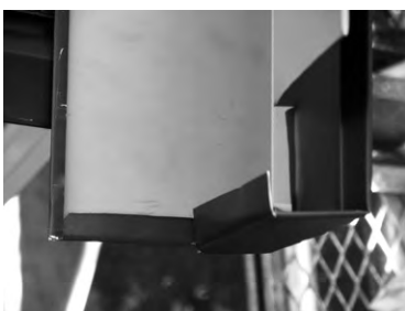
けらば水切85軒先部の加工例
