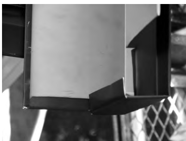
けらば水切85軒先部の加工例
