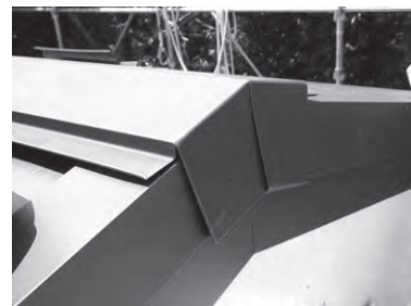
③ 棟包み210を写真のように加工し、けらば水切85(110)にかぶせます。
