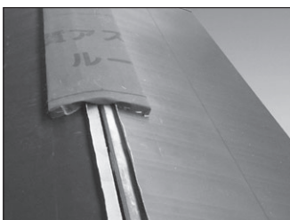
下葺材の施工
