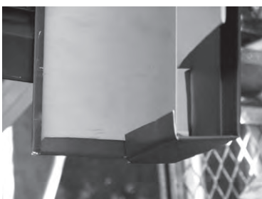
けらば水切85軒先部の加工例
