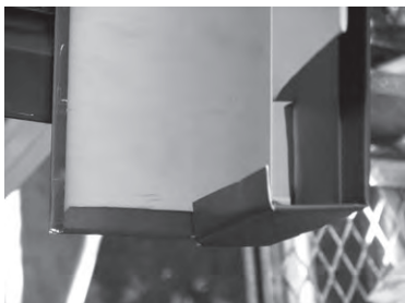
けらば水切85軒先部の加工例
