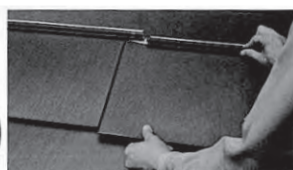
施工イメージ(UP)
