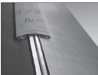
下葺材の施工
