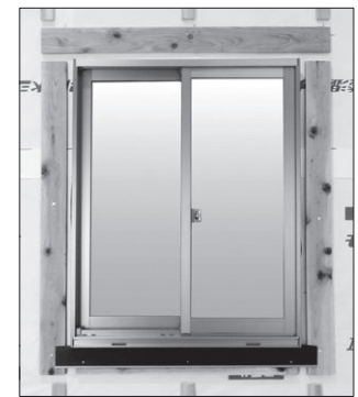
開口下に鋼板下地部材の取り付け
