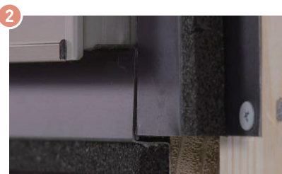
図3 鋼板下地材Ⅱの施工
