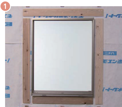
図1 胴縁の施工
