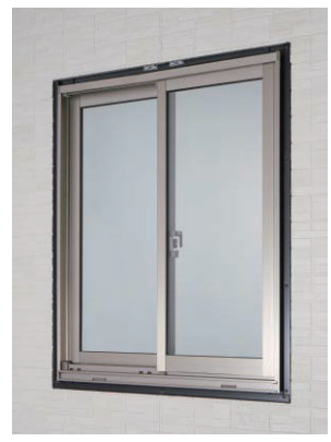
▲サッシ横にアルミ開口ベース材Iを留め付ける
