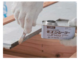
▲スリット加工部とモエン切断小口にモエンシーラーを塗布する (2回塗り)
