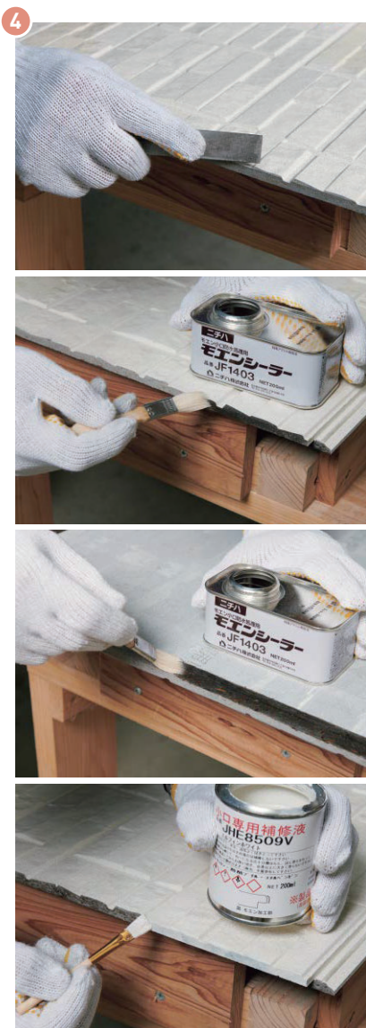
▲モエン加工部を補修塗装する
