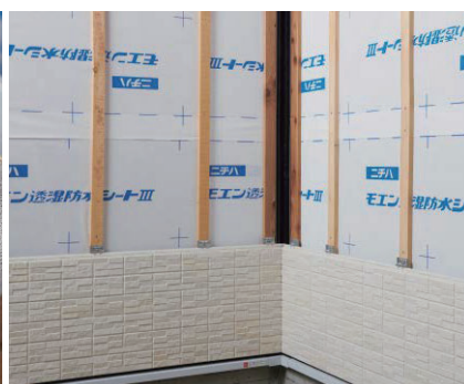
▲留付金具EXであと施工モエンを施工する
