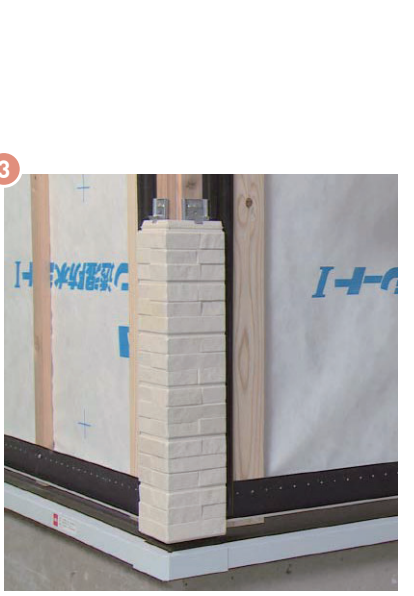
▲留付金具EX出隅用で同質出隅を取り付ける
