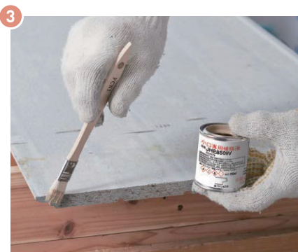
▲モエン切断小口面を補修塗装する
