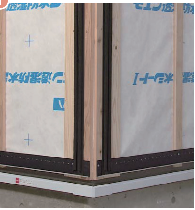
▲接合部用部材をモエン用釘または専用ビスで留め付ける
