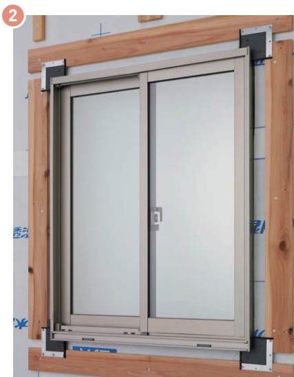
▲鋼板下地材I(コーナー用)を同梱ビスで留め付ける
