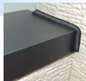
▲外壁側モエンと笠木の取り合いにシーリングを施工する
