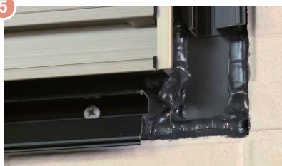
図8 捨てうちシーリングの施工
