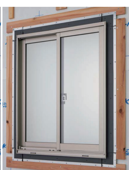
▲鋼板下地材Ⅰ（一般部用）を同梱ビスで留め付ける
