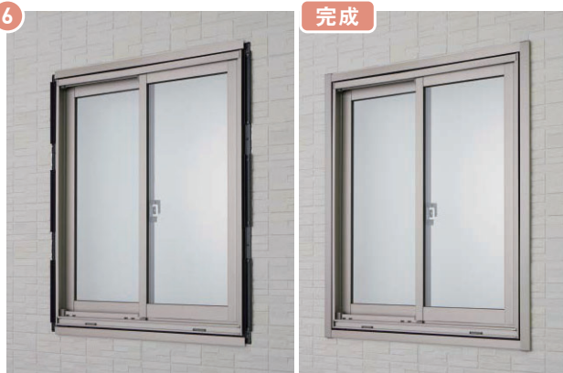
図7 アルミ開口トップ受け材Iの施工
