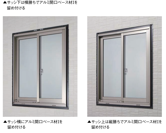
図6 アルミ開口ベース材Iの施工
