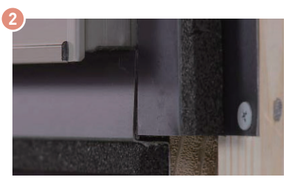
▲鋼板下地材Ⅱを同梱ビスで留め付ける
