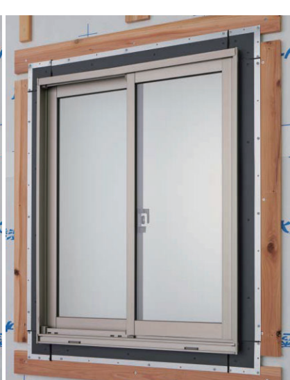
▲鋼板下地材I(一般部用)を同梱ビスで留め付ける
