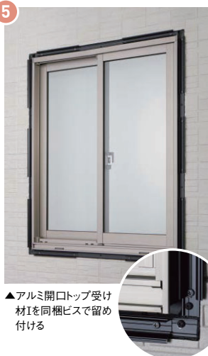
図7 アルミ開口トップ受け材Iの施工
