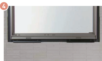
▲アルミ開口トップ受け材Ⅱを同梱ビスで留め付ける
