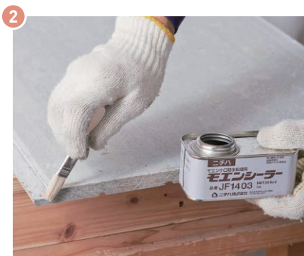
▲ モエン切断小口面にモエンシーラーを塗布する (2回塗り)
