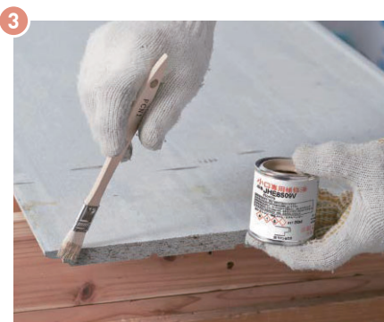
▲モエン切断小口面を補修塗装する
