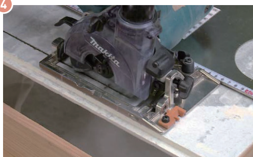
図4 モエン小口部の補修塗装
