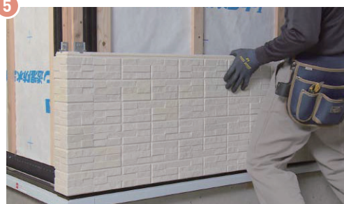
▲留付金具EXでモエン本体を施工する
