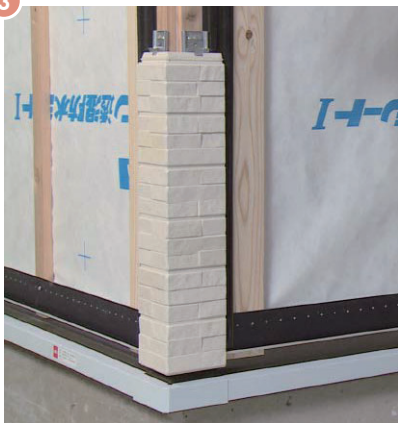
▲留付金具EX出隅用で同質出隅を取り付ける
