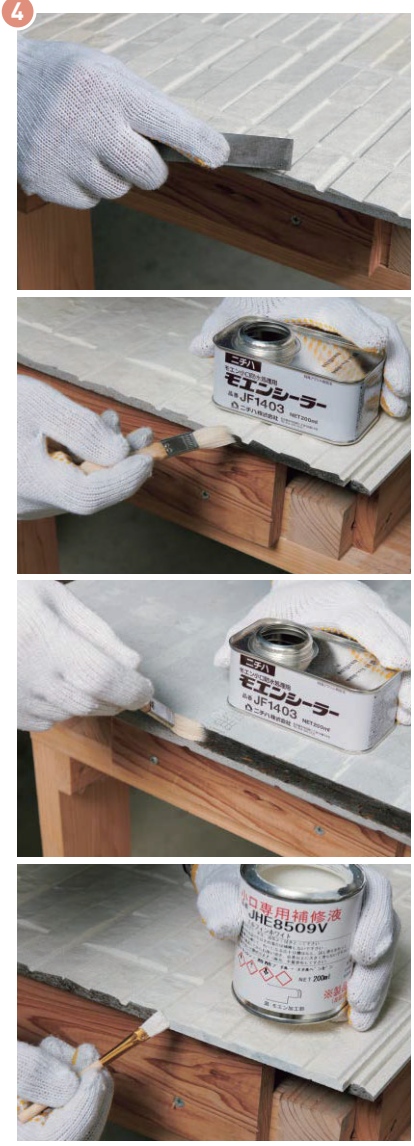
▲モエン加工部を補修塗装する
