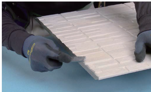
▲モエン表面端部に面取り加工を施し、補修塗装する
