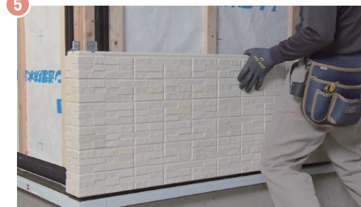
▲留付金具EXでモエン本体を施工する
