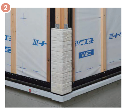
▲留付金具EX出隅用で実付同質出隅を取り付ける
