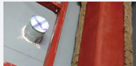
柱・梁合成被覆2時間耐火構造、マキベエ(耐火被覆材)取り付け施工中の様子。
