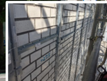
金属胴縁15の施工中
