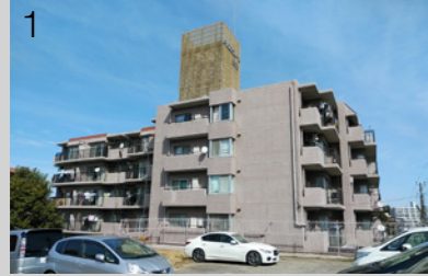
1. 改修前の外観。既存の外壁はRC躯体にタイル調の塗装を施したものの。2. 大規模改修を経て蘇った外観。建物のイメージが180度変わり、重厚感・高級感が増した印象。
