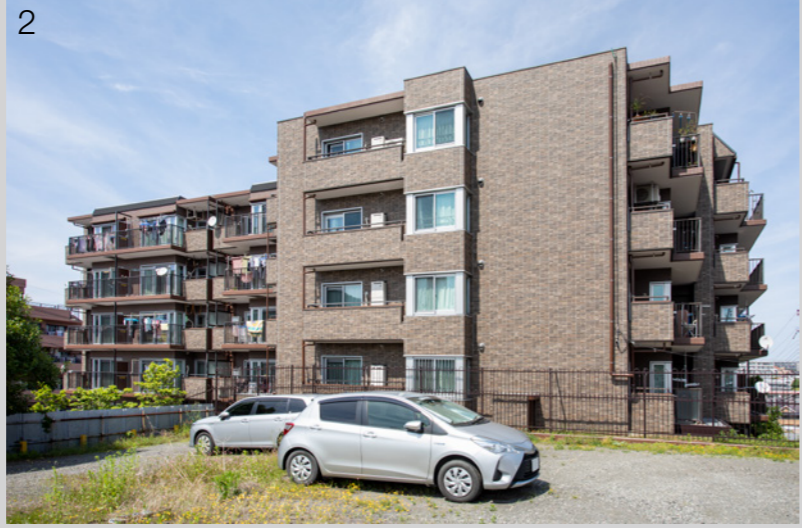
1. 改修前の外観。既存の外壁はRC躯体にタイル調の塗装を施したものの。2. 大規模改修を経て蘇った外観。建物のイメージが180度変わり、重厚感・高級感が増した印象。
