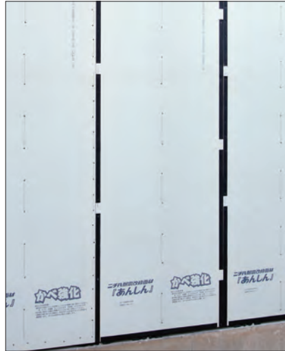
高倍率仕様施工の様子
