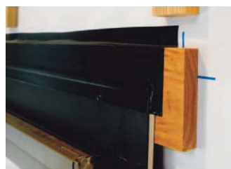
鋼板止水部材・防水紙に15mm以上重なるように貼る
