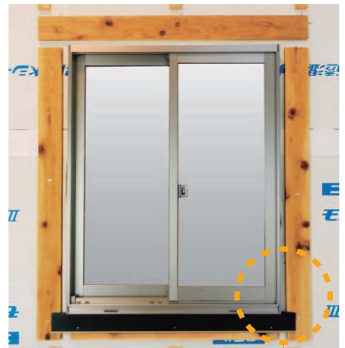
部材両端のT字部の切断加工
