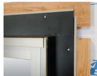
サッシ横に取り付けた部材の上に重なるように施工
