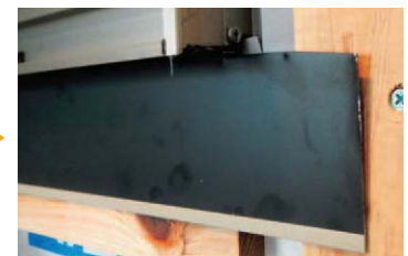
鋼板止水部材をサッシ面に押しつけながら胴縁に留め付けます
