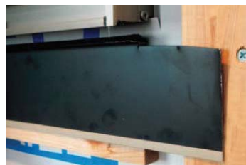
鋼板止水部材をサッシ面に押しつけながら胴縁に留め付けます
